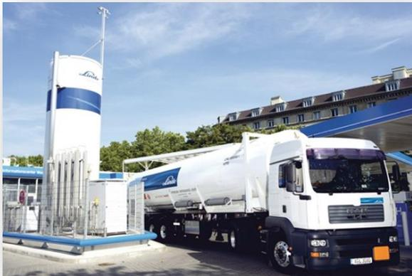
LH<sub>2</sub>: Befüllung Flüssigwasserstoff-Stationärtank
