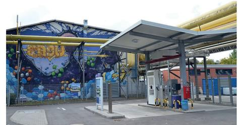
Die Erzeugung von Wasserstoff am Point of Sale setzt die Anbindung an eine Energiequelle voraus. Die Wasserstofftankstelle am Standort Stuttgart wurde mit einem Elektrolyseur ausgestattet, der zukünftig proportional zum Angebot des erneuerbaren Stroms gesteuert werden kann. Die Pilotanlage ist nach Fertigstellung bis zu 2,5 Jahre öffentlich zugänglich und steht damit allen Brennstoffzellenfahrzeug-Pionieren zur Verfügung.
