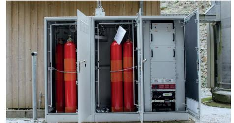
Als Brennstoffzellentyp werden Polymerelektrolytbrennstoffzellen eingesetzt. Der Leistungsbedarf an den Standorten liegt im Bereich zwischen 2,0 bzw. 2,5 kW. Die Brennstoffversorgung erfolgt durch den Einsatz von komprimiertem Wasserstoff in Druckgasflaschen. Die Funkstandorte können bei einem Stromausfall damit bis zu 100 Stunden versorgt werden. Durch den Einsatz von Druckgasflaschen ist eine schnelle Nachlieferung von Wasserstoff vergleichsweise unkompliziert möglich.
