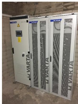
Bild: HVG, Pufferspeicher zur Nutzung des Stroms der eigenen PV-Anlage zum Laden der Busse
