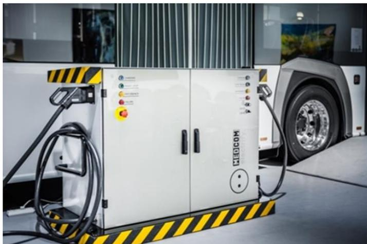
Bild: In-der-City-Bus GmbH, Ladestation mit 2xCCS Stecker (primär für Batteriebusse)
