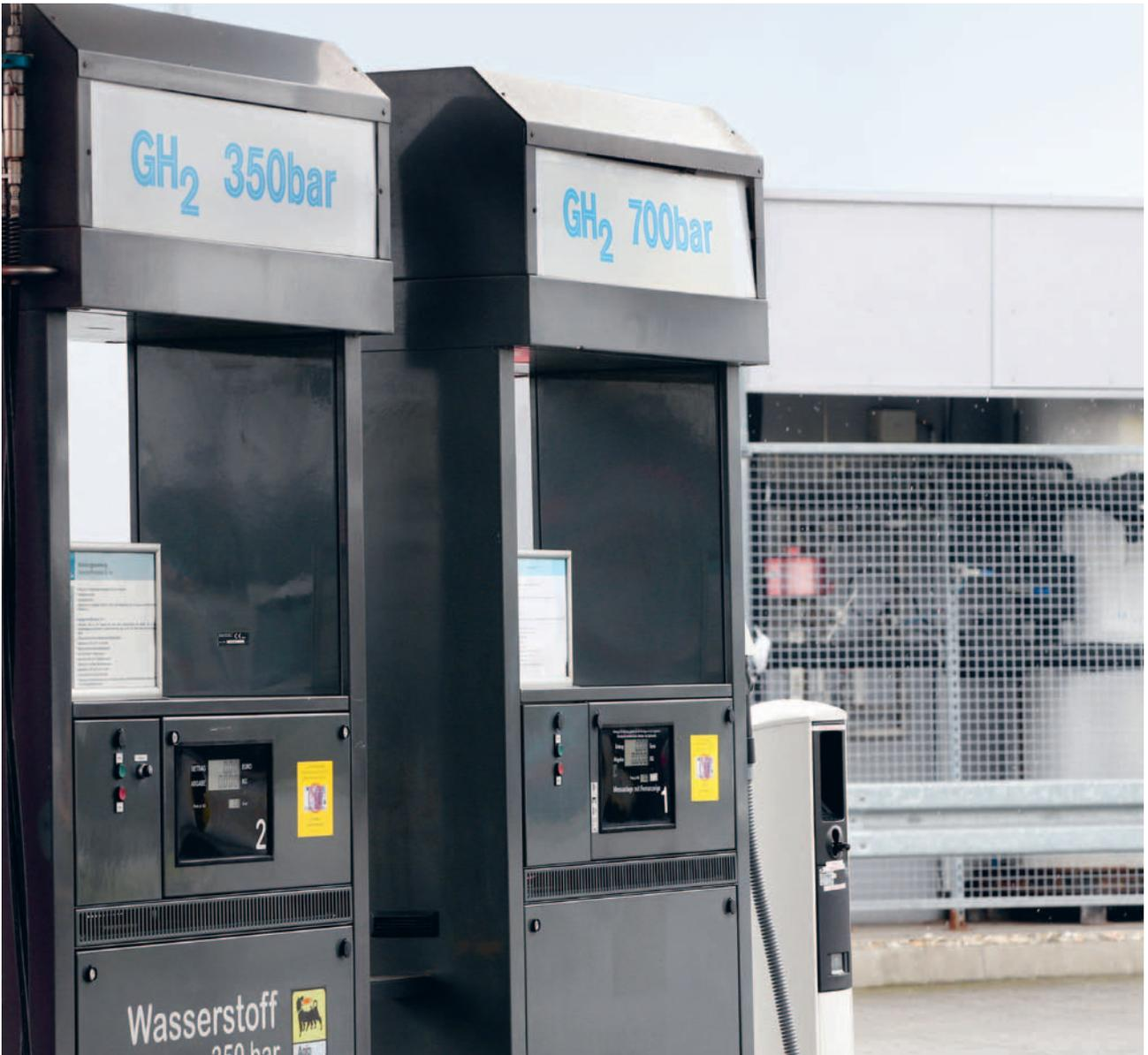
An der Wasserstofftankstelle in unmittelbarer Nähe des Industrieparks Höchst können sowohl Brennstoffzellen-Busse (350 bar) als auch Autos (700 bar) betankt werden.
