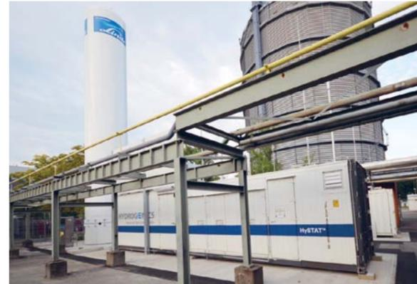
Die Erzeugung von Wasserstoff am Point of Sale setzt die Anbindung an eine Energiequelle voraus. Die Wasserstofftankstelle am Standort Stuttgart wurde mit einem Elektrolyseur ausgestattet, der zukünftig proportional zum Angebot des erneuerbaren Stroms gesteuert werden kann. Die Pilotanlage ist nach Fertigstellung bis zu 2,5 Jahre öffentlich zugänglich und steht damit allen Brennstoffzellenfahrzeug-Pionieren zur Verfügung.
