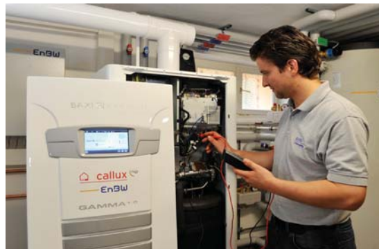
Abbildung 12: Monteur bei Einstellarbeiten
